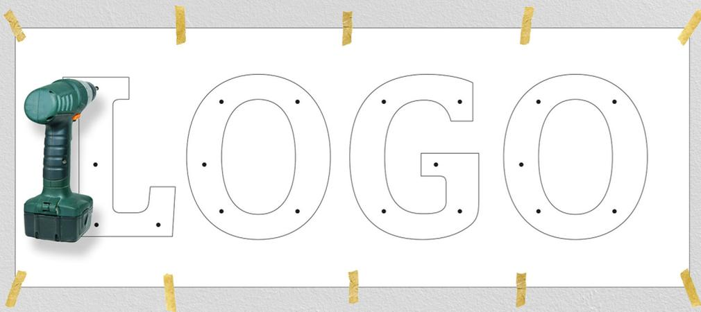
Befestigen Sie die 1:1 Zeichnung mit etwas Klebeband an der Wand und bohren Sie die Löcher durch die Zeichnung in die Wand. Dies sind die Löcher für die EasyFix Distanzhalter und die Stromkabel.
