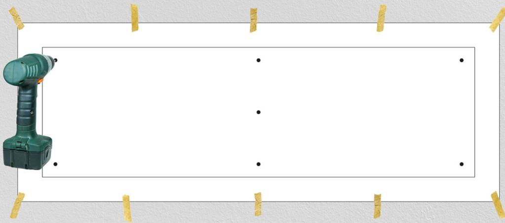
Befestigen Sie die 1:1 Zeichnung mit etwas Klebeband an der Wand und bohren Sie die Löcher durch die Zeichnung in die Wand. Dies sind die Löcher für die Befestigung der Grundplatte.
